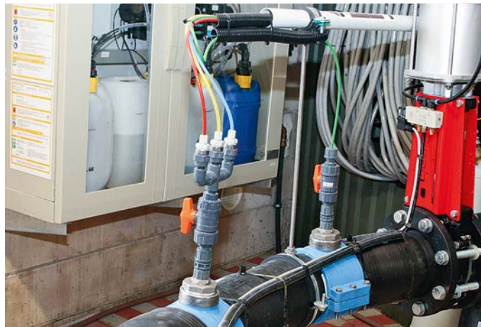
Über die vier Ventile an der Substratléitung dosiert DosiPro Enzyme und verschiedene Spurenelemente in das Gärsubstrat. Die genaue Menge wurde zuvor auf Basis von Labor-Ergebnissen ermittelt.
