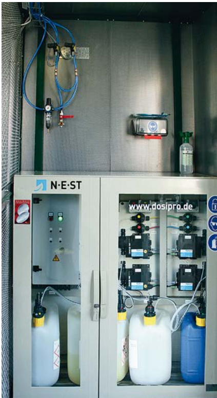
In dem abschließbaren Schrank sind die Kanister und Dosierpumpen sowie die elektronische Steuerung der Dosieranlage untergebracht.
